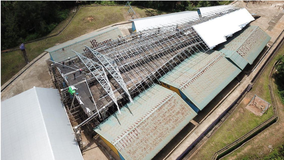
het overkoepelende dak over de speelplaats van de lagere school in opbouw
